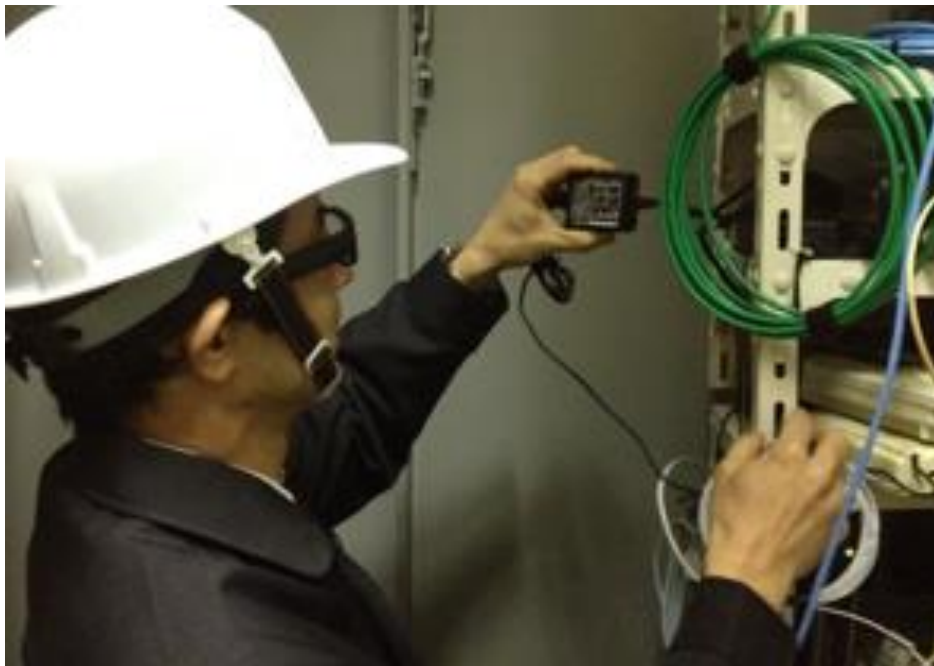
図2 メガネ型カメラを装着した現場の作業員
